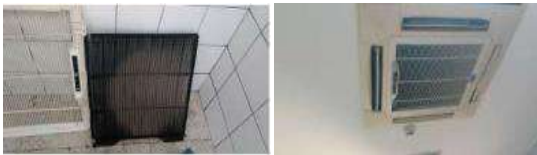
Situacional final de equipamentos após reparo e troca de peças.
