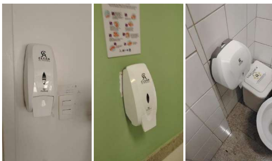
Readequação de Dispensers retirados e danificados.
