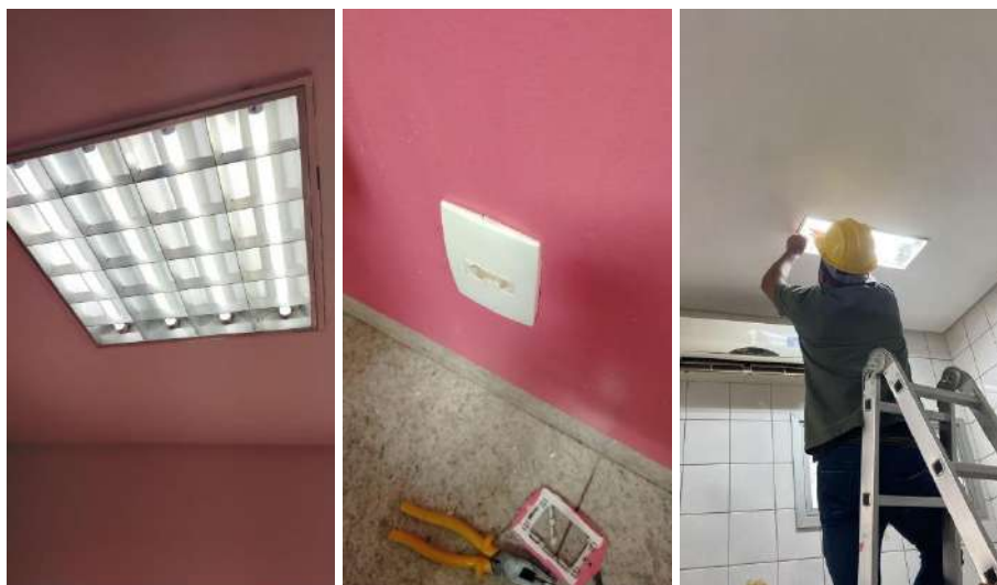
Reparos e reestruturação realizados.
