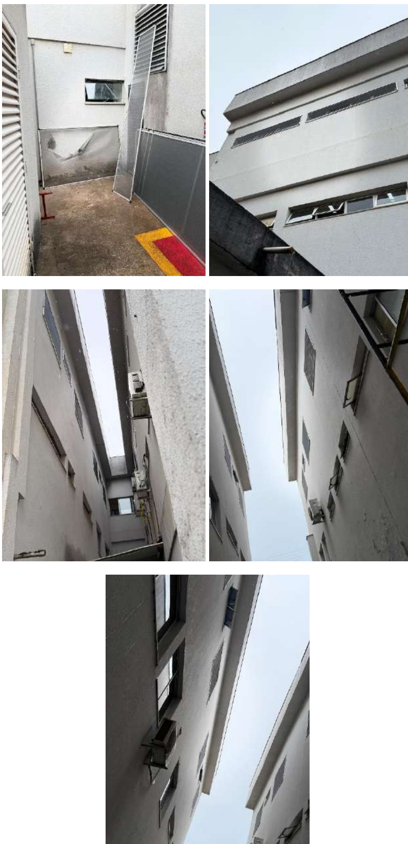
Serviço em andamento, substituição de telas mosquiteiras.
