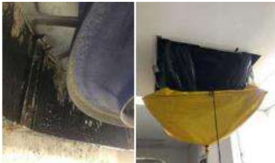
Reparo e Limpeza em máquinas Cassete obstruídas
