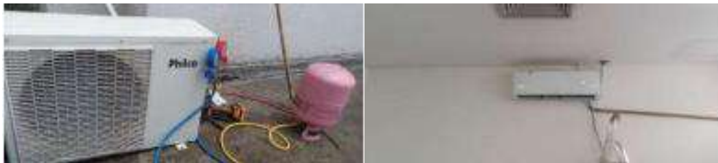
Reparo e reabastecimento do compressor
