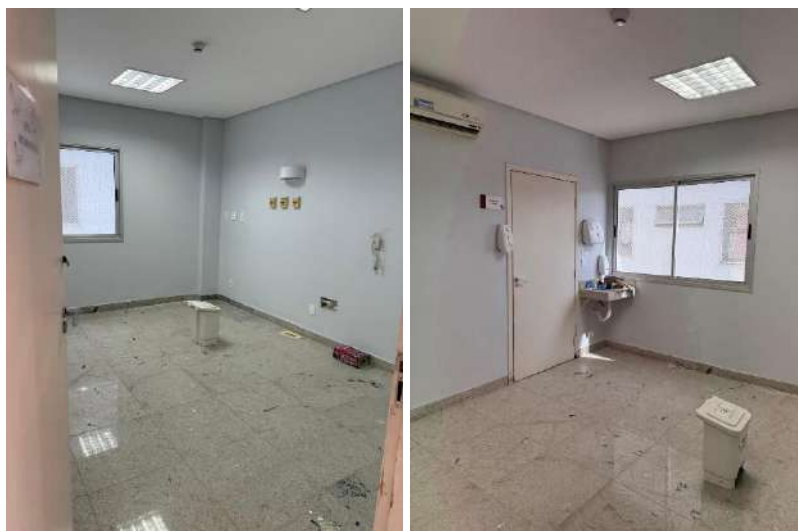
Leitos reestruturados para o acolhimento da gestante.
