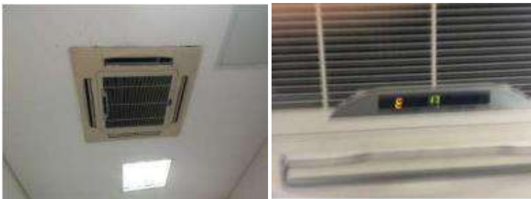
Reparos Realizados, equipamentos funcionando
